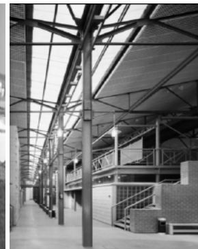
Εικόνα 97: Διατήρηση υπάρχοντος μεταλλικού σκελετού ) που στεγάζει σχολές του Πανεπιστημίου Θεσσαλίας.
